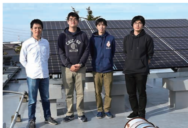
野田キャンパス12号館屋上に設置した太陽光発電システム
